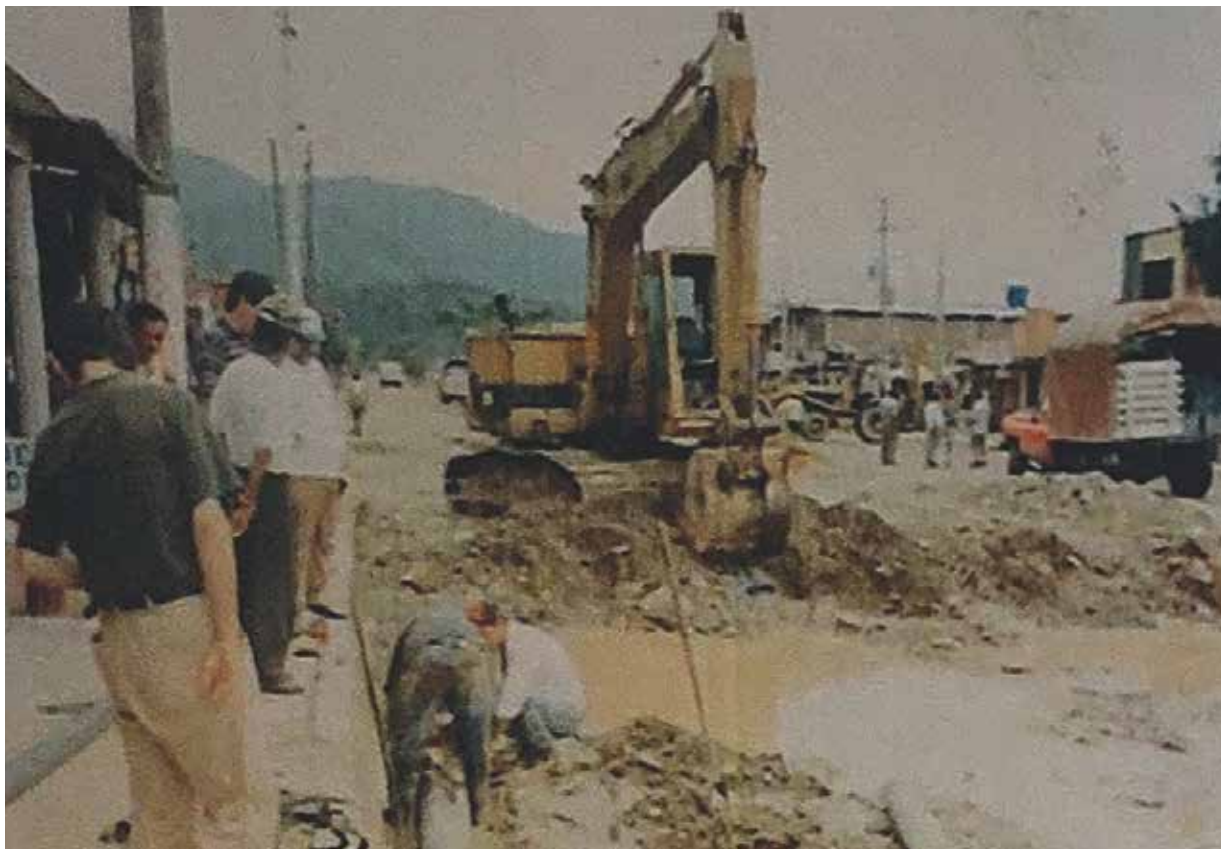
Fotografía 23 Instalación de tubería del acueducto comunitario de Ciudad Porfía en la década de los noventa. Sin fecha. Créditos: Museo Comunitario de Porfía
