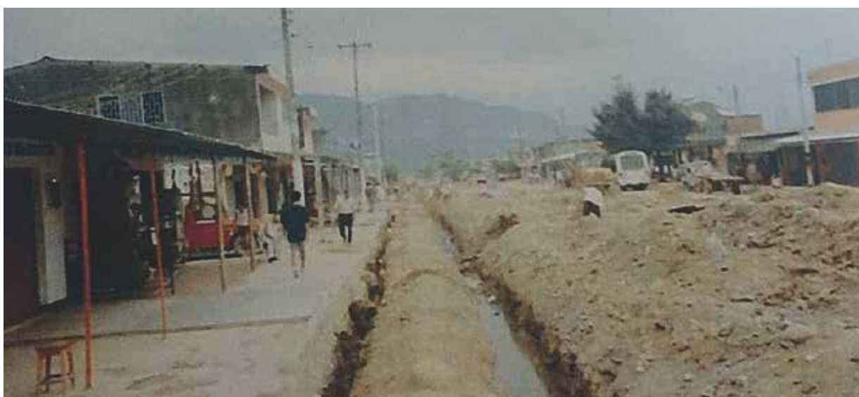
Fotografía 24 Instalación de tubería del acueducto comunitario de Porfía en la vía principal en la década de los noventa. Sin fecha. Créditos: Museo Comunitario de Porfía
