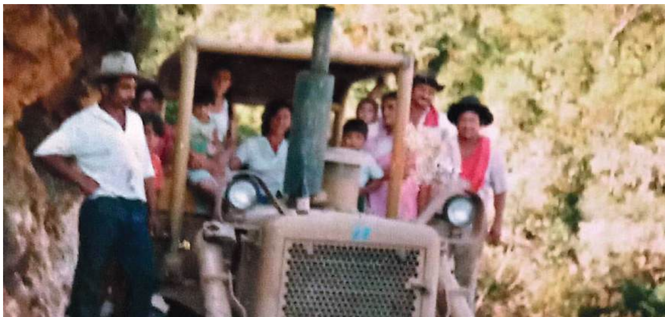
Fotografía 2 Construcción de la carretera de la vereda San José Alto a Santa Teresa. De izquierda a derecha el señor Justo Martínez, su hijo Francisco Martínez, Carmen Velázquez, John Mancera, Inirida Ortiz (de camisa blanca), Teresa Parrado, operarios del bulldozer (de pañoleta roja), y Manuel Antonio Mancera. Créditos: Luz Dary Mancera, presidente JAC.
