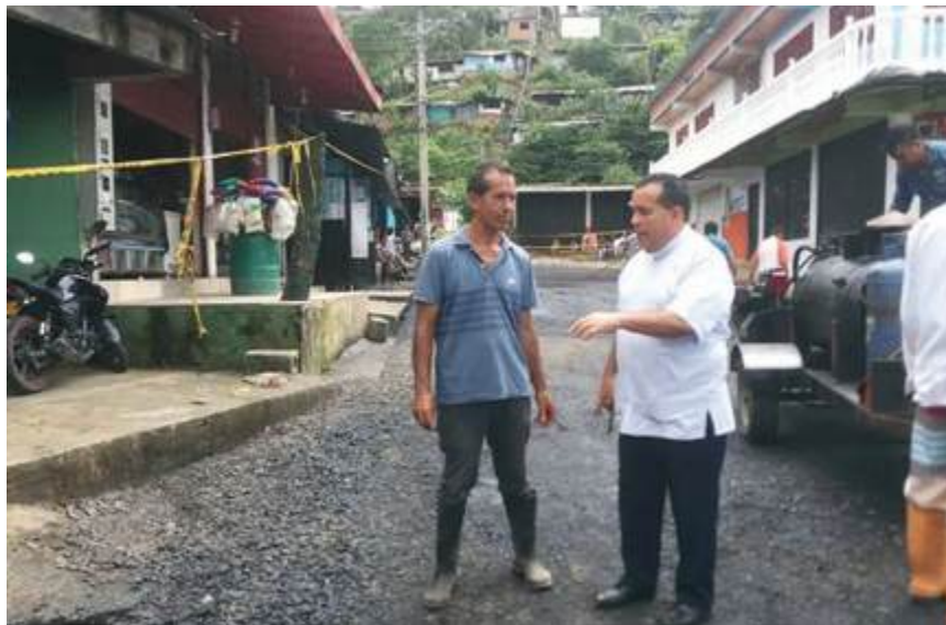
Fotografía 44 Trabajos de pavimentación de la vía principal, Realizados por la JAC con acompañamiento del Padre Carlos Mario. Sin fecha. Créditos: Nubia Edith Moreno Vidal
